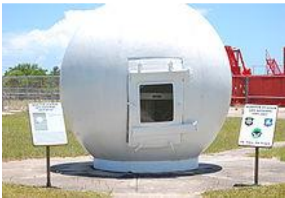
Figura 1.28 – stazione di controllo a terra
